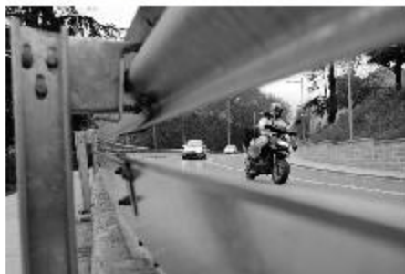
Un motorista circulando por una carretera con guardarrailes.FOTO: JAVIER BERGASA
